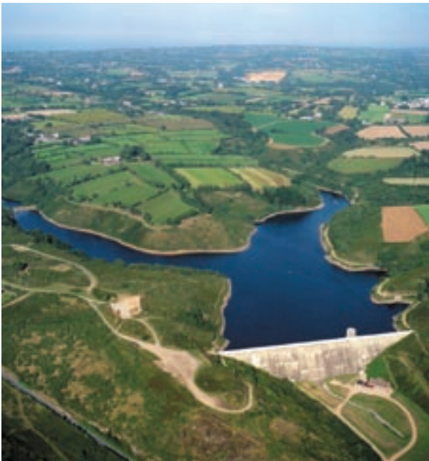
Val de la Mare Reservoir
